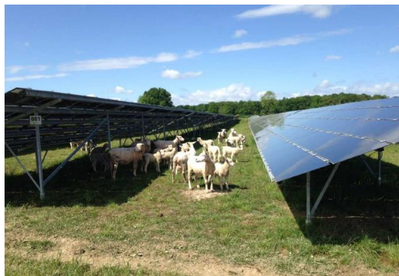
Figure 51 : Centrale de Gennetines dans l'Allier septembre 2015, source PHOTOSOL
