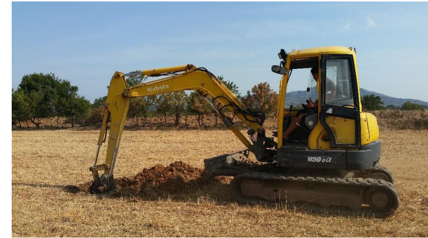
Figure 43 : Photo de la réalisation des fosses pédologiques
