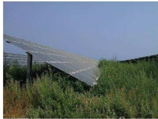
Parc solaire de Toreilles (66)
